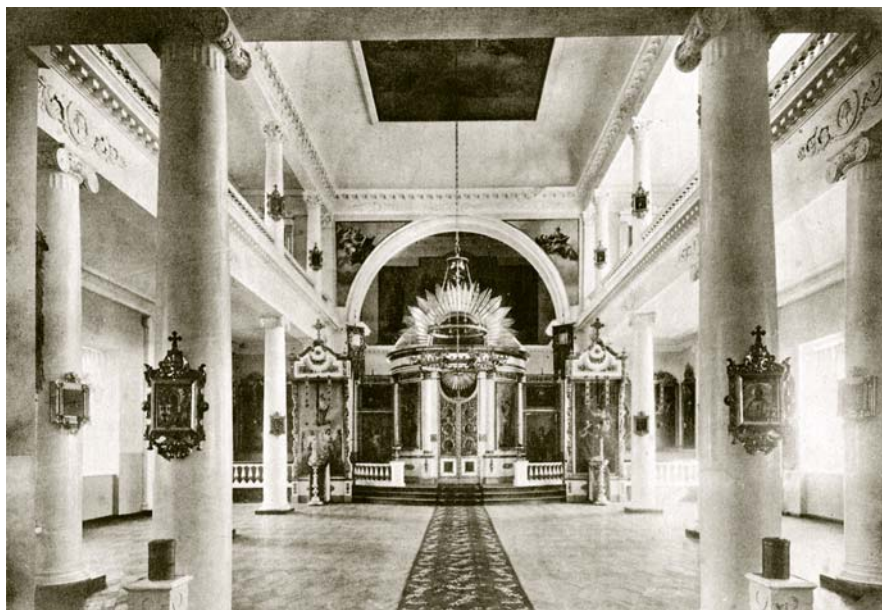
Домовая церковь в Кадетском корпусе. 1890-е годы
