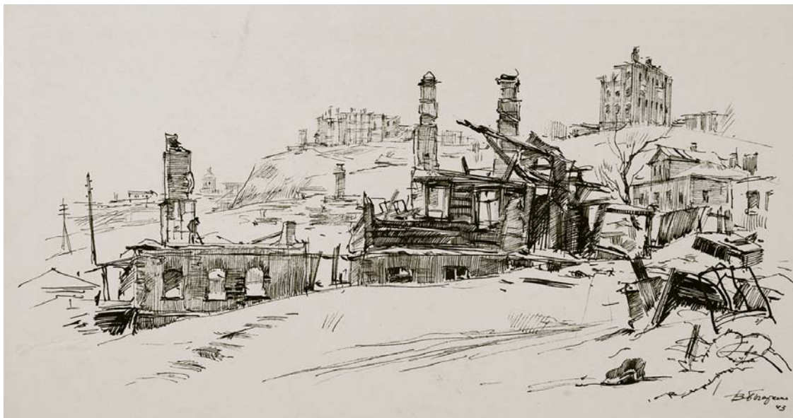
Разрушенные дома на улице Плехановской (художник В. В. Богаткин). 1943 год. Из собрания Воронежского областного художественного музея имени И. Н. Крамского
